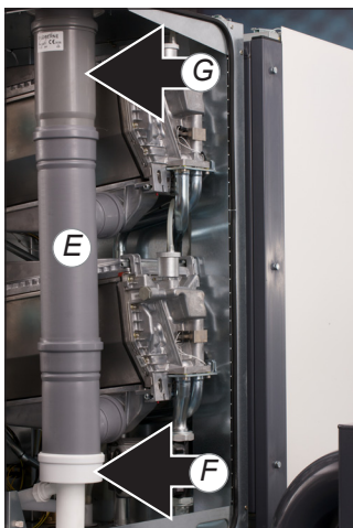
Rimuovere il condotto interno Figura 3
