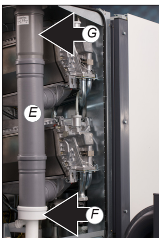
Rookgasafvoerpijp uitbouwen Figuur3
