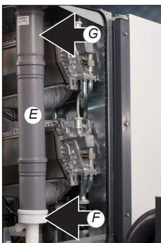
Abgasrohr entfernen Bild 3
